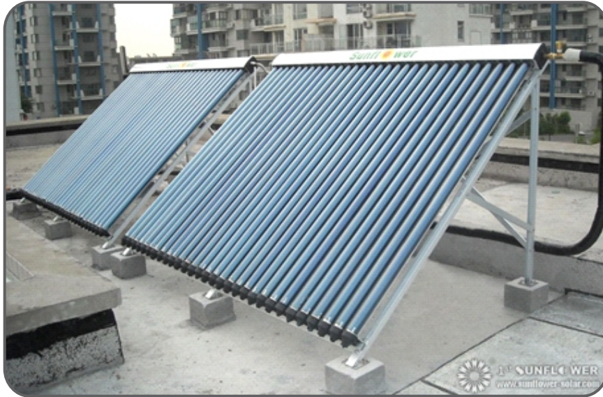
الشكل (٨): تركيب القواعد على المكعبات الإسمنتية في سطح غير معزول بـرولات زفتة.
