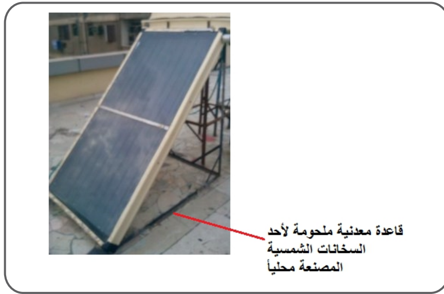
الشكل (١١): قاعدة معدنية لأحد السخانات المصنعة محلياً.
