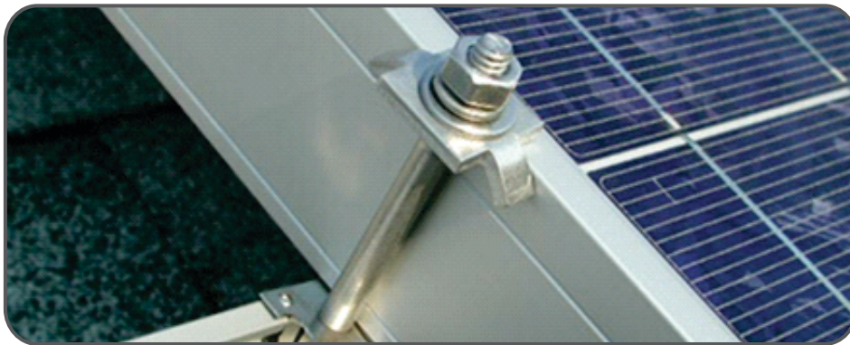
الشكل (٧): تثبيت الخلايا الكهروضوئية
