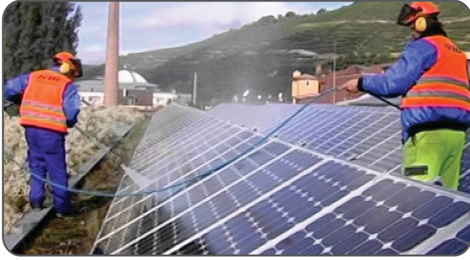
الشكل (٤): تنظيف الخلايا الضوئية بالماء.
