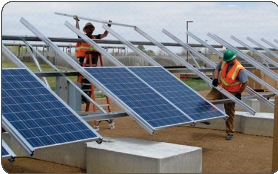
الشكل (٥): هيكل تركيب النظام الكهروضوئي
