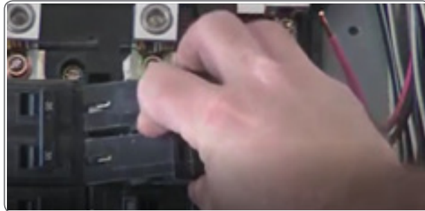
الشكل (١٥): تركيب القواطع الجديدة.
