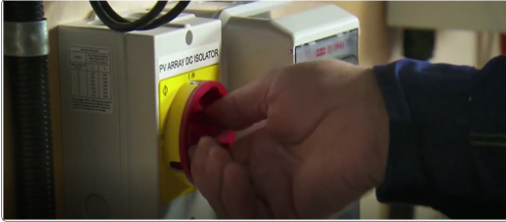
الشكل (٢): فصل التيار المباشر بين الألواح وبقية أجزاء النظام الكهروضوئي عن طريق فاصل التيار المباشر.
