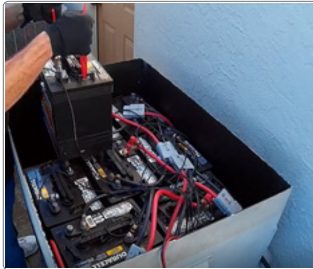
الشكل (٨): إزالة المركم التالف.
