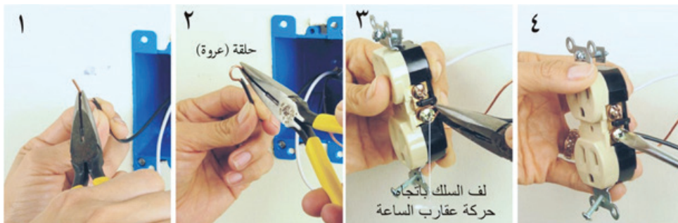
الشكل (١٦): تشكيل طرف السلك الكهربائي على شكل حلقة (عروة) عند وصله ببرغي التوصليل.
