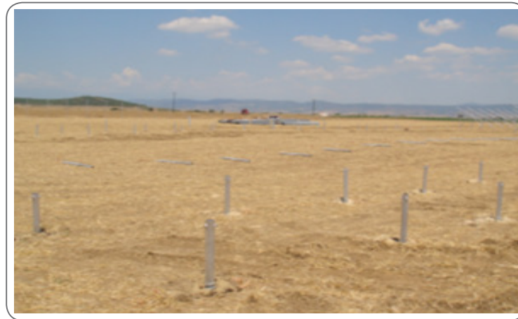
الشكل (٣): نقل العلامات على الأرضية من المخطط/نقاط التثبيت.
