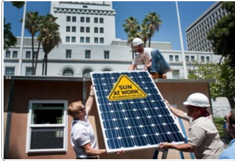
الشكل (١١): رفع الألواح لشمسية الكهروضوئية إلى السطح.
