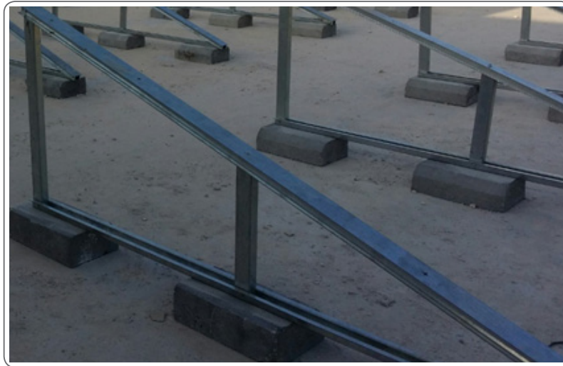
الشكل (٩): القوالب الأسمنتية الجاهزة (أحجار الأرصفة المسماة كندرين) التي تستخدم لتثبيت الأعمدة في الأنظمة الكهروضوئية.
