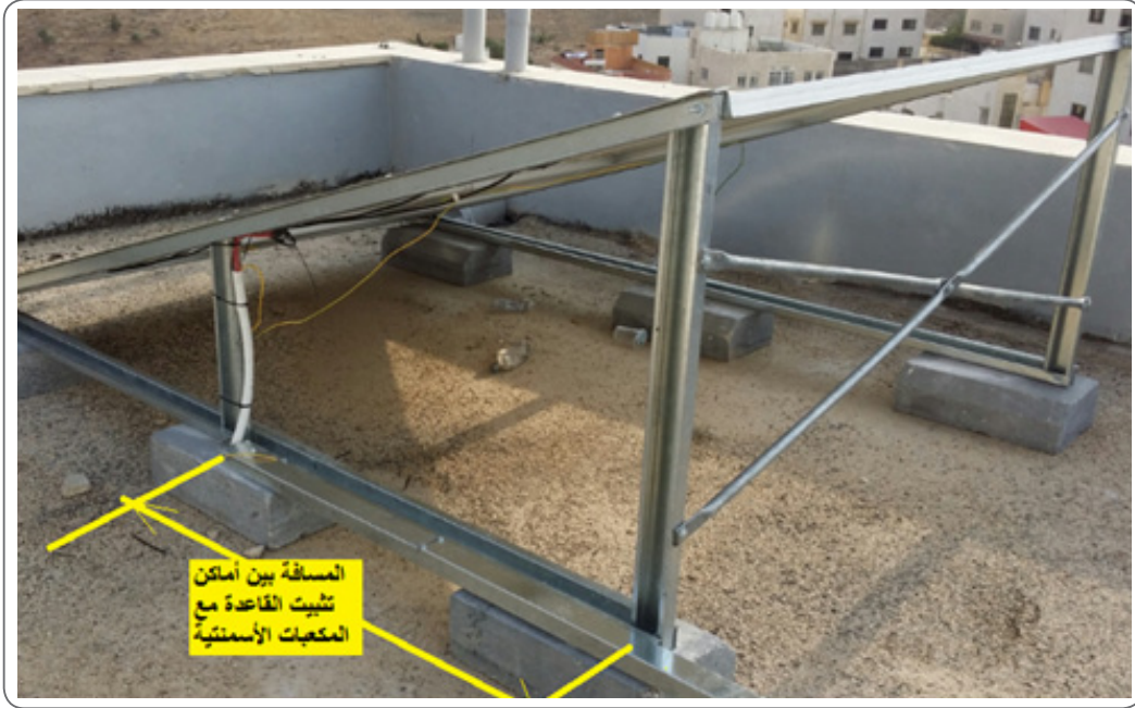
الشكل (١٣): المسافة بين أماكن تثبيت القاعدة مع المكعبات الأسمنتية.
