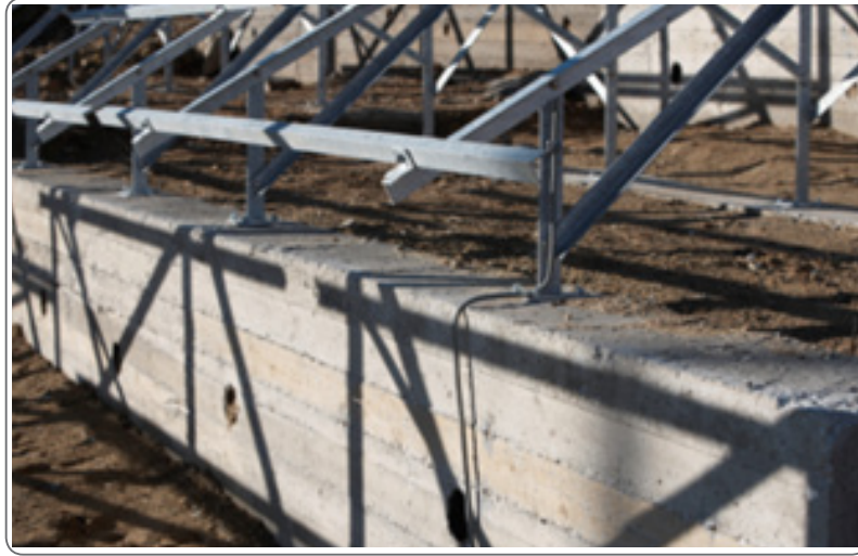
الشكل (١): تثبيت الدعائم على الأساس الخرساني.
