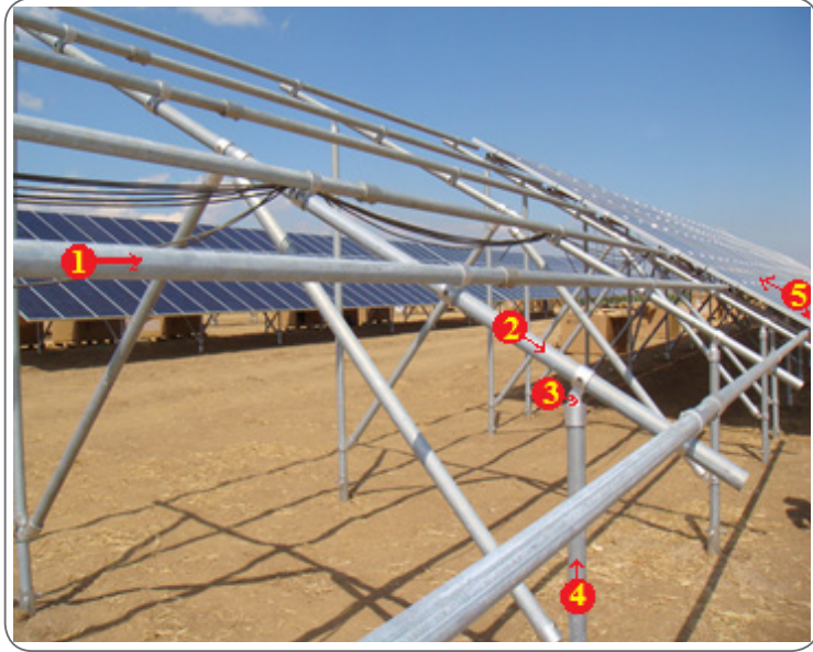
الشكل (١٨): يوضح نظام كهروضوئي، يظهر فيه الجسور والدعامات.
