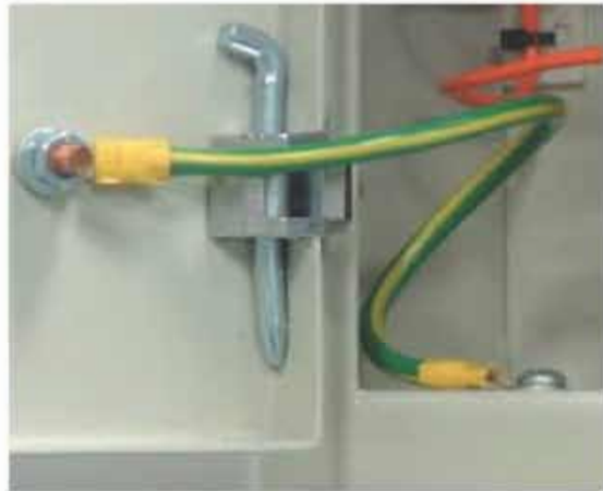
أ-وصلة باب لوحة التوزيع المرنة
