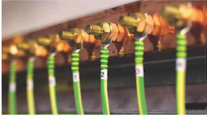
الشكل (25): توصيل موصلات الوقاية وتساوي الفولطية مع جسر التأريض الرئيس.
