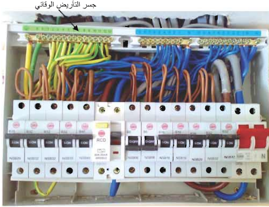
الشكل (8): جسر التأريض الوقائي في لوحة التوزيع الفرعية.
