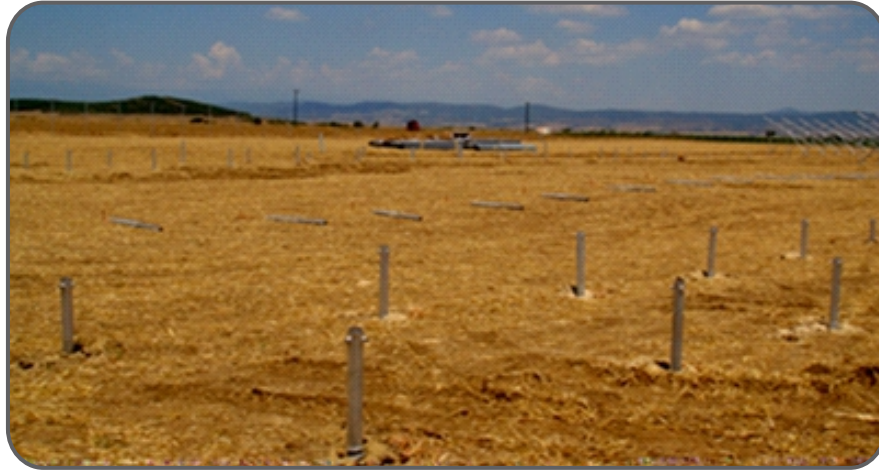
الشكل (١٢): تحديد جميع النقاط الهامة على الأرض.
