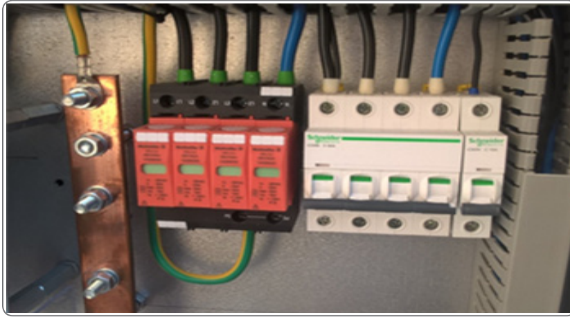
الشكل (٨): وصلات التيار الثابت والمتناوب.
