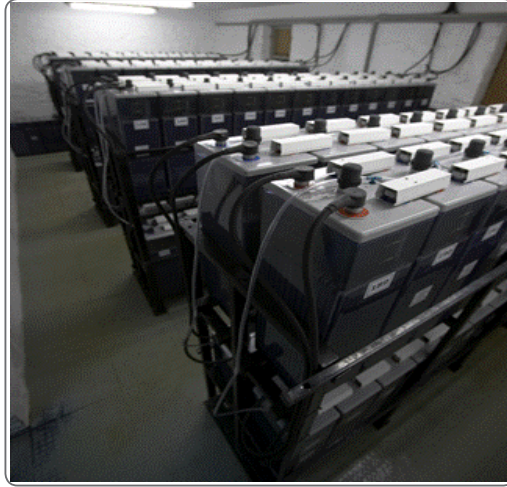
الشكل (٢٧): مراكم مفتوحة، ٢ فولط، ١٥٠٠ أمبير ساعة.
