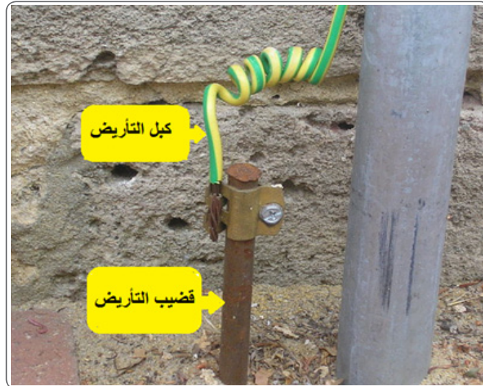
الشكل (١٣): مكونات نظام التأريض.
